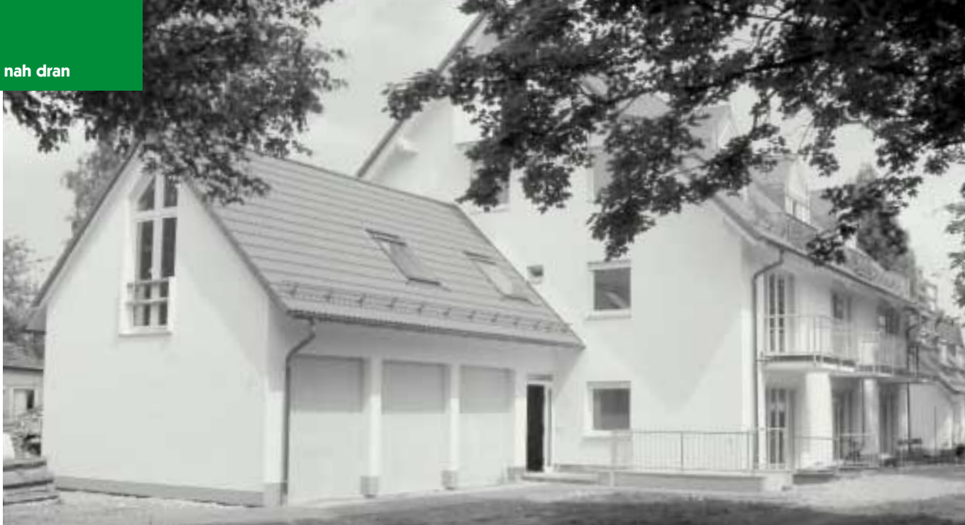
Das neue Haus des AEH-Regionteams Ramersdorf/Perlach in der Feichtstraße 5 wird demnächst bezogen
